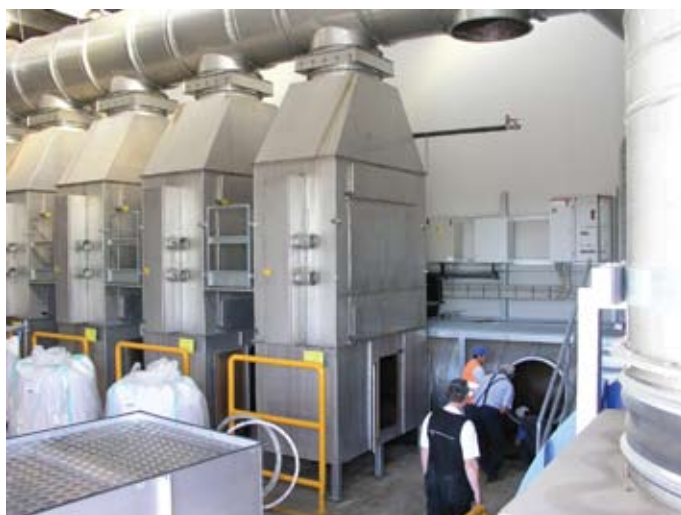
Figur 1. Installasjon av NTP-anlegg fra APP for luktfjerning fra en dyrefôrfabrikk.
